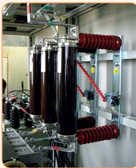
Установка внутренних держателей предохранителей*
