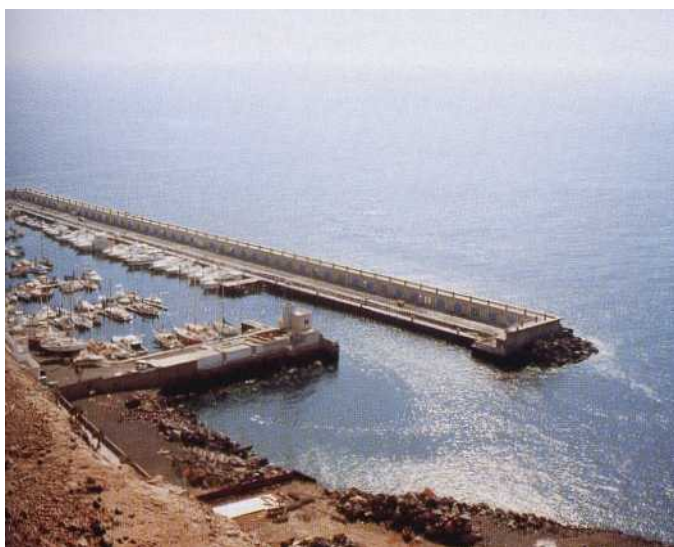
Puerto Radazul depuis le nord-ouest. Les bateaux de passage se mettent normalement contre le quai vide que l'on voit derrière le bureau de la marina, situé sur le môle nord.
