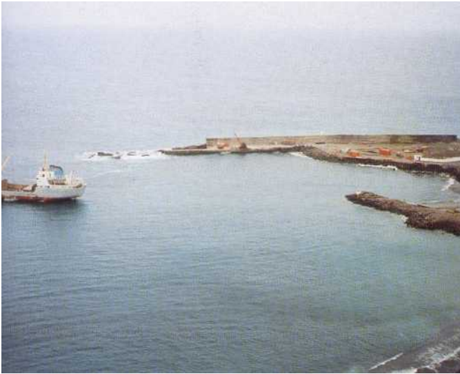
Le mouillage de Vale de Cavaleiros, à quelque 1,5 M au nord de São Filipe, en 1993. On voit les débris de la jetée effondrée et on devine les aussières arrières du cargo amarrées à la jetée et sur le rivage. La jetée est maintenant reconstruite.
