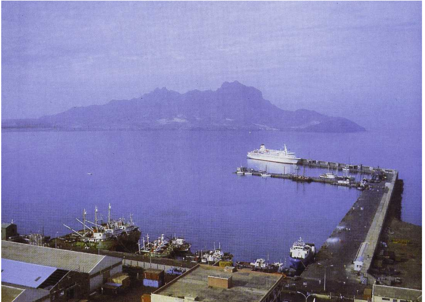
Le brise-lames principal de Porto Grande devant le Monte Branco et la Ponta Chao de Sal, vus depuis l'est. Depuis la prise de la photo, le quai intérieur a été élargi et allongé.
