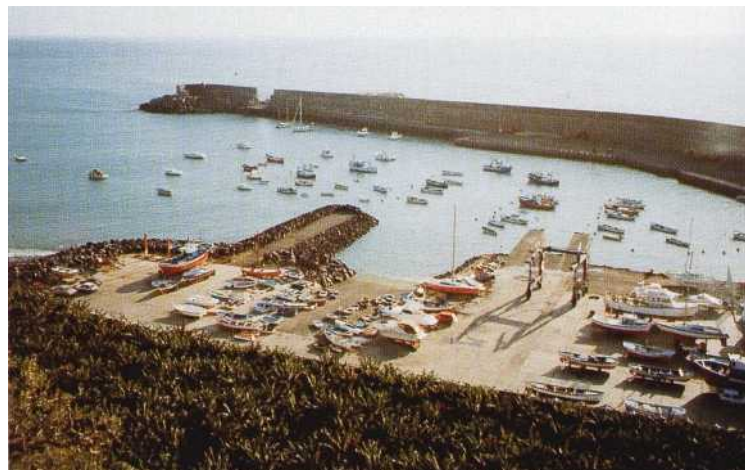
Des travaux étaient en cours sur le brise-lames de Puerto de Tazacorte en mars 1998. L'avancée partant à angle droit du brise-lames se devine au-delà du mur massif. La balise bâbord est juste au-dessus du bateau le plus à gauche.
