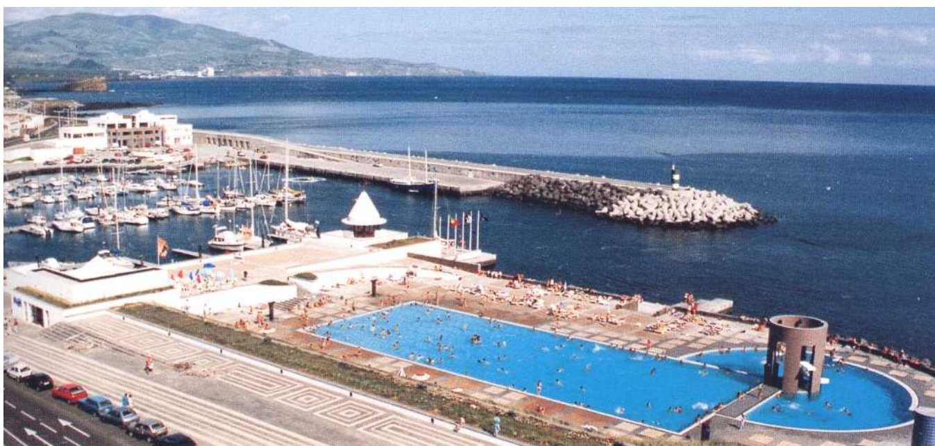
La marina de Ponta Delgada n'abrite pas seulement près de 140 bateaux pouvant atteindre 40 m, mais aussi deux piscines et plusieurs restaurants et cafés. Le grand bâtiment blanc au début du môle est le club house du très accueillant Clube Naval de Ponta Delgada.
