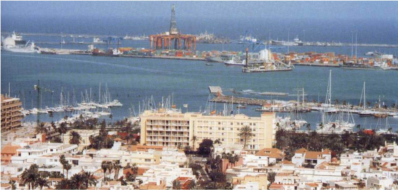
L'entrée du port de plaisance de Puerto de la Luz en mars 1998. Un môle a été construit plus tard dans l'année et sérieusement endommagé par les tempêtes du Nouvel An 1999 alors qu'il était presque achevé.
