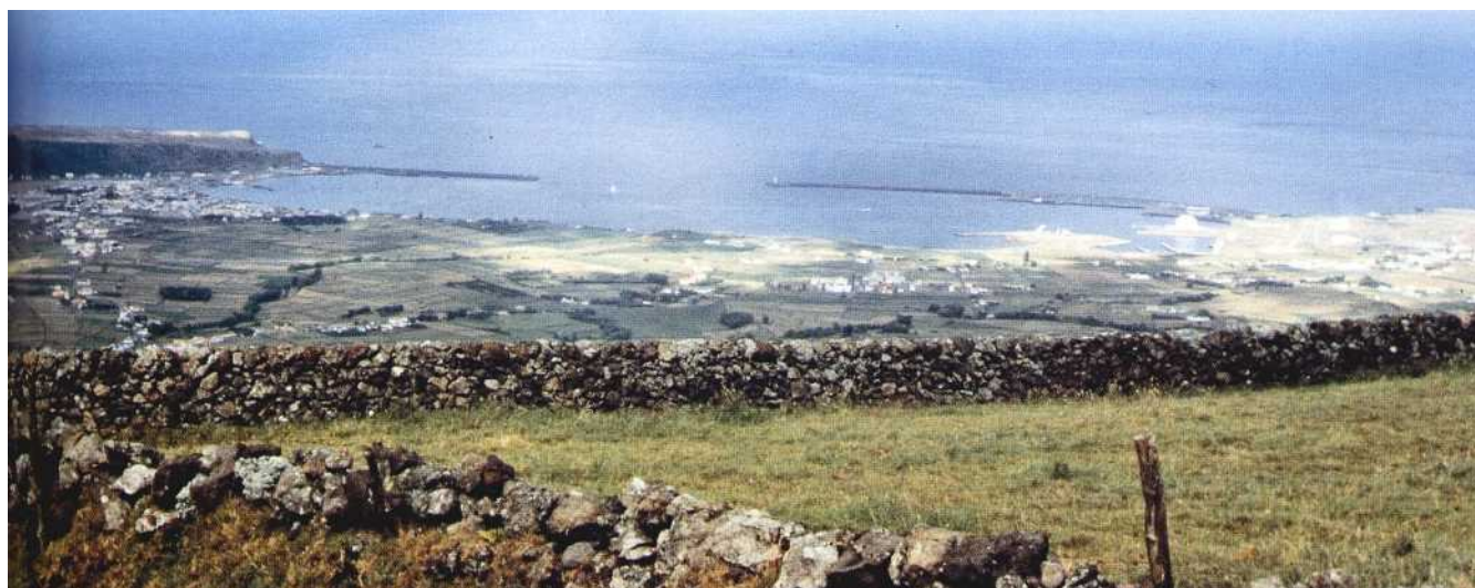
Cette vue lointaine depuis l'ouest donne une idée de la longueur des deux jetées de Praia da Vitória.
