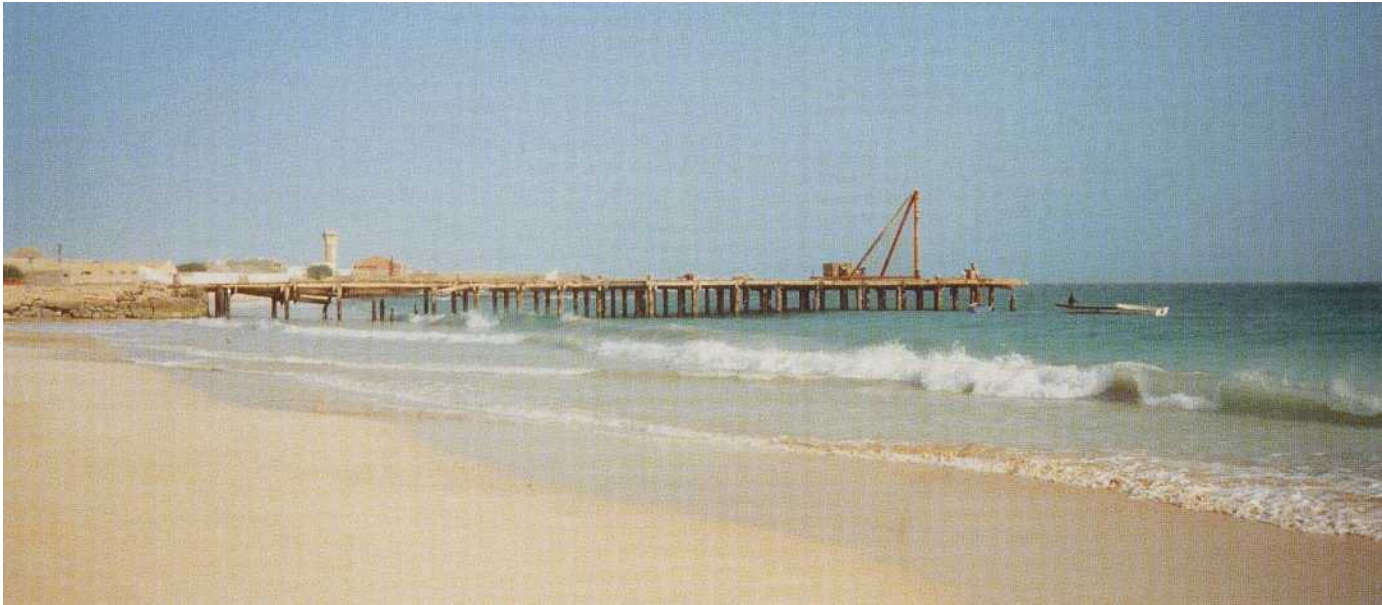
La vieille jetée et la superbe plage de Santa Maria vues depuis l'ouest. On voit un château d'eau et le phare de Ponta de Vera Cruz - le bâtiment blanc trapu à droite.
