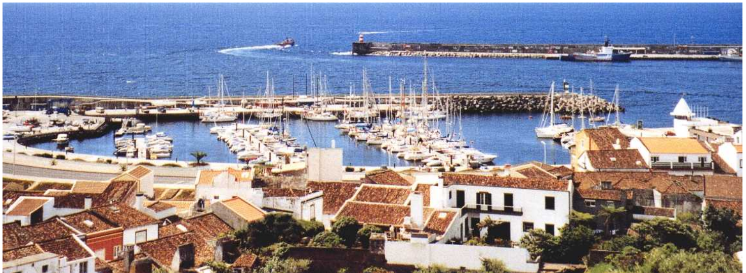
Marina de Ponte Delgada, en regardant vers le sud-sud-est avec le brise-lames en fond. Un chalutier quitte en contournant largement l'extrémité de la jetée qui n'est pas saine.
