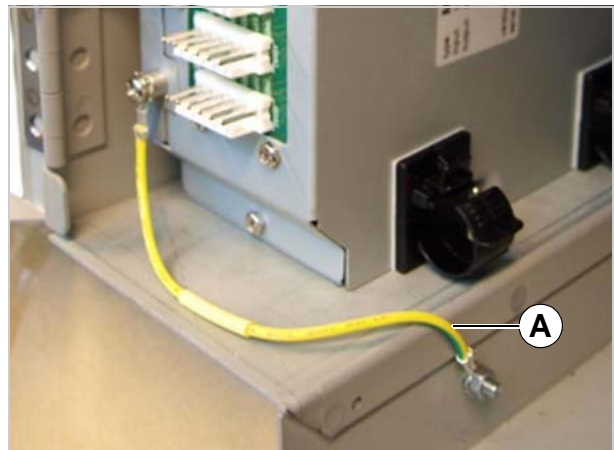
[226] (Nur LH) Befestigung des Massekabels (A) am Gehäuse.
