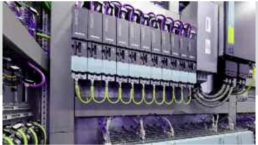
Blick in den Steuerschrank. Die grosse Zahl der sicheren Sinamics S120 weist auf die hohe Achsen-Anzahl hin.
