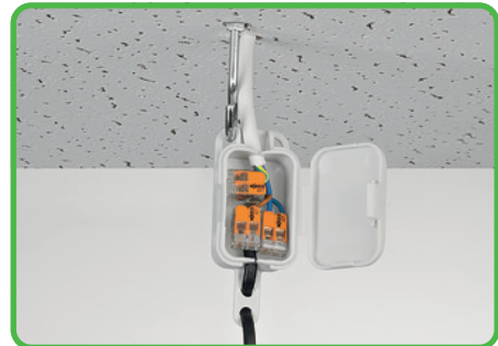
Anschluss von Pendelleuchten in abgehängten Decken
