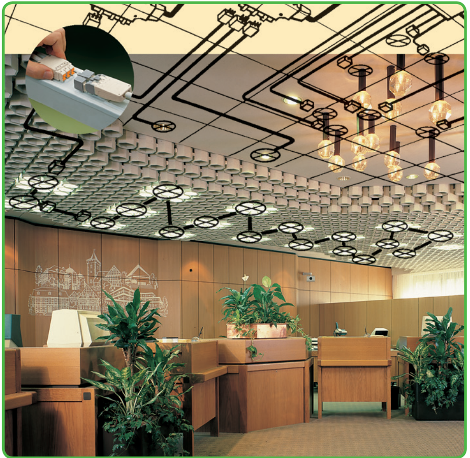
Anschlussfertige Leuchte mit Kupplungsverbinder (interne Verdrahtung komplett mit WAGO-Klemmen)
