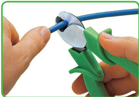
Abschneiden der Leitung
