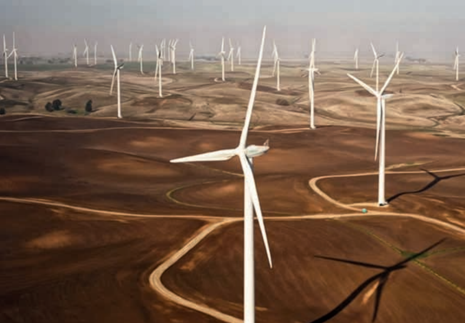
▲ Gesamtleistung 355 MW: enXco Windpark Shiloh II, III und IV im Solano County, Kalifornien (USA). Dort stehen 175 Turbinen des Typs MM92.
