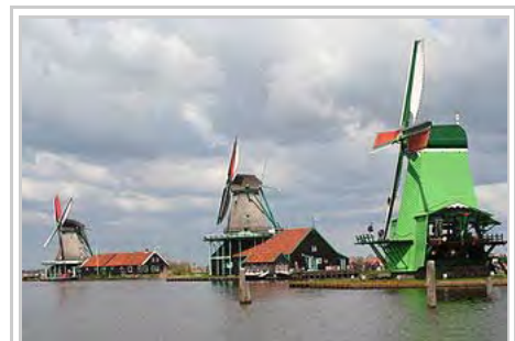
Oilmill De Zoeker, paintmill De Kat and paltrok sawmill De Gekroonde Poelenburg at the Zaanse Schans
