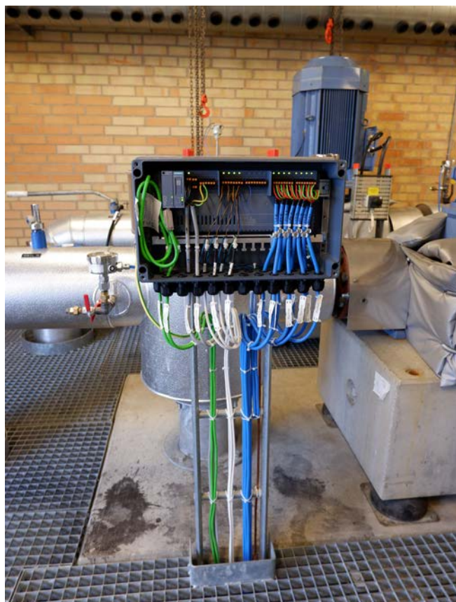
CFU'en set forfra med/uden dæksel. PA-instrumenterne tilkoblet til højre, digitale signaler i midten og PROFINET-forbindelsen længst til venstre.
