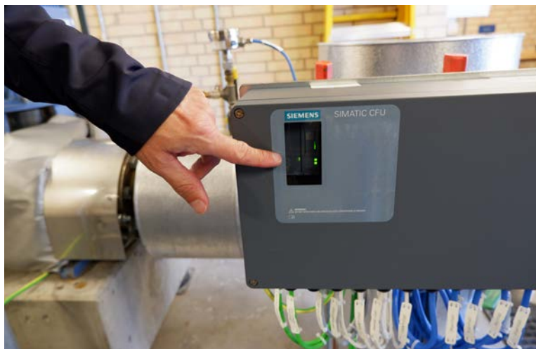
CFU'en set forfra med/uden dæksel. PA-instrumenterne tilkoblet til højre, digitale signaler i midten og PROFINET-forbindelsen længst til venstre.
